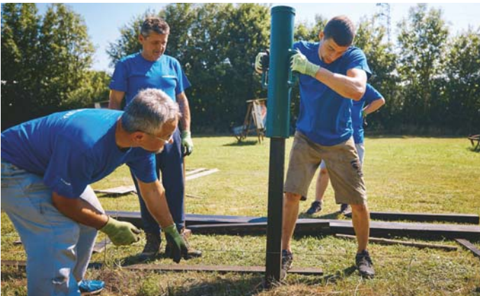
Postavitev ograje za Klub lokostrelcev Kranj
