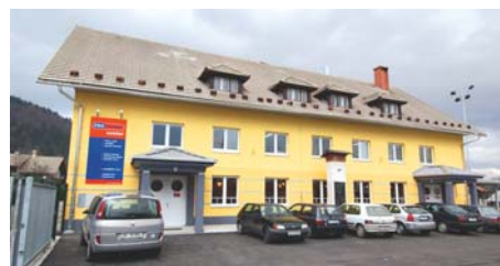
PROŠPORT – posodobljen objekt nekdanjega Sokolskega doma in TVD Partizan
